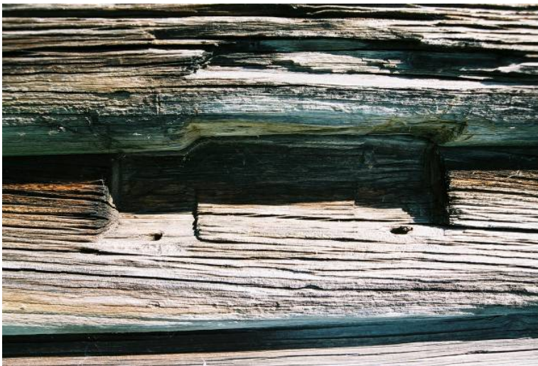
Bild 32. Detalj av urhugg med hål efter pluggar på A-vägg. Jlm 06m56/27
