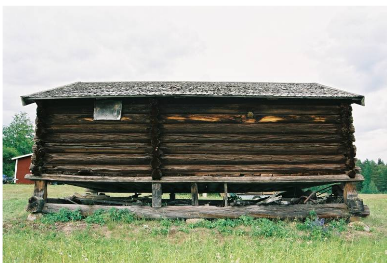
Bild 38. Dubbelbodens C-vägg. Jlm 06m54/29
