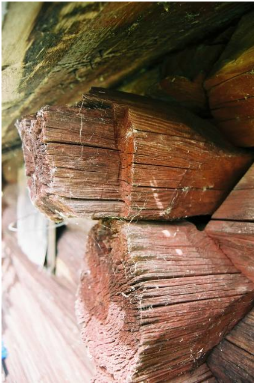
Bild 18. Detalj på droppnäs på E8. Jlm 06m56/7
