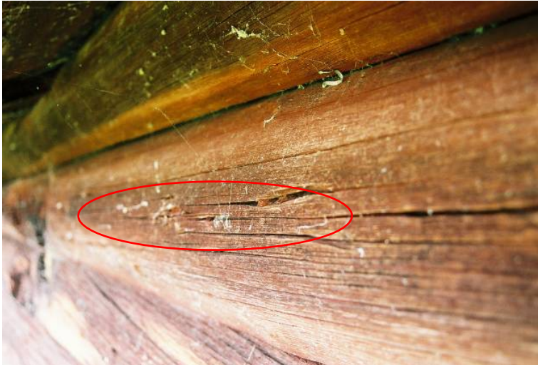
Bild 17. En mängd små kilar är inslagna i de översta stockarna. Jlm 06m56/6
