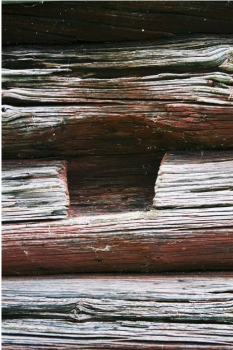
Bild 19. Detalj av laxat urtag med rundning i överliggande stock. Jlm 06m56/9
