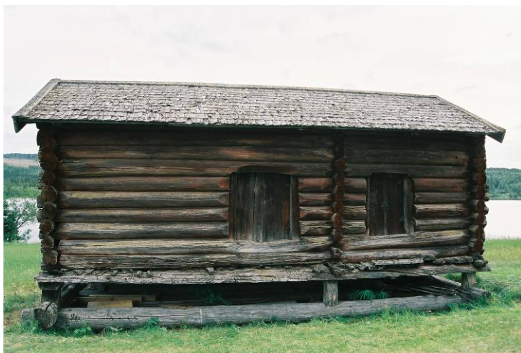
Bild 36. Dubbelbodens A-vägg. Jlm 06m54/27
