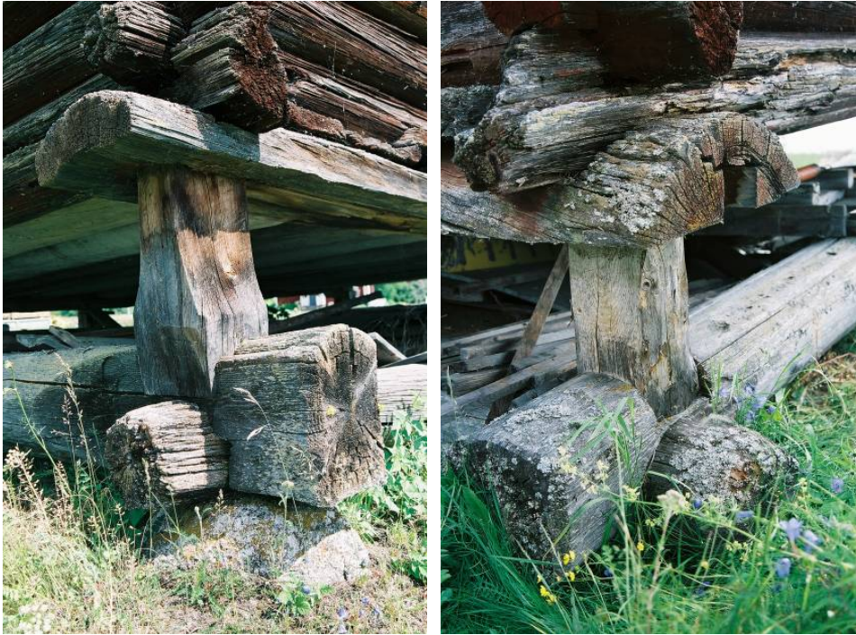
Bild 6-9. Hörnstolparna, från överst till vänster till nederst till höger: AB-, BC-, CD- & AD-hörn. Jlm 06m54/5, 4, 1 & 7.
