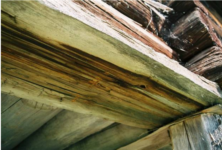
Bild 10. Mushyllan vid C-vägg sedd underifrån. Lägg märke till den, med undantag av kanterna, obearbetade ytan. Jlm 06m54/2
