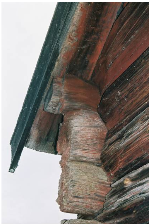
Bild 16. Väggbandens knutskallar är formade med droppnäsa. Jlm 06m54/36
