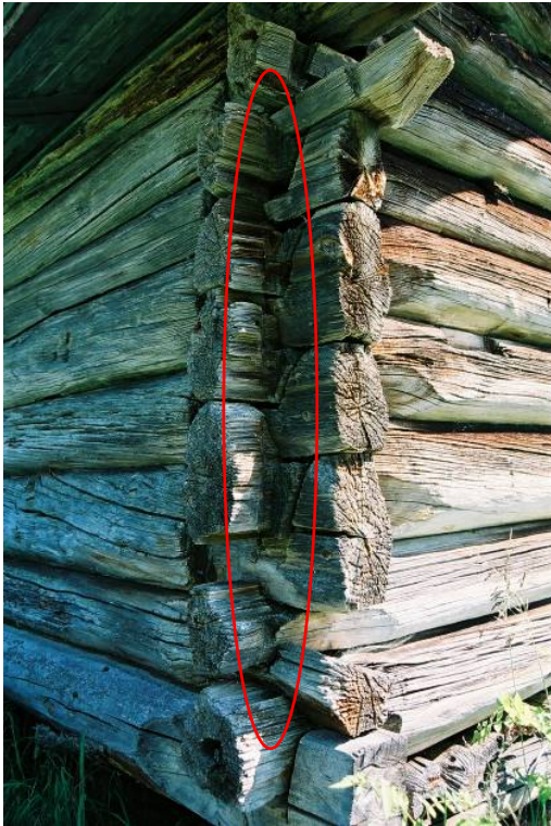
Bild 33. AB-knut. Urhugg tyder på att något stått intill knuten. Jlm 06m56/26
