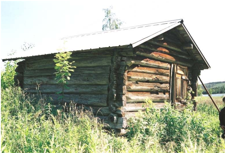
Bild 40. Ladans A- och B-vägg. Jlm 06m56/20
