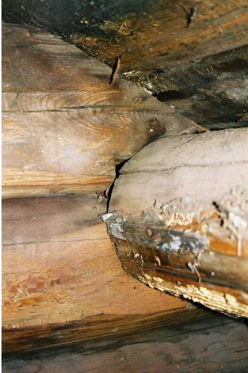
Bild 21. Detalj av sidoåsens infällning i B-väggen. Notera de sågade spåren. Jlm 06m56/16
