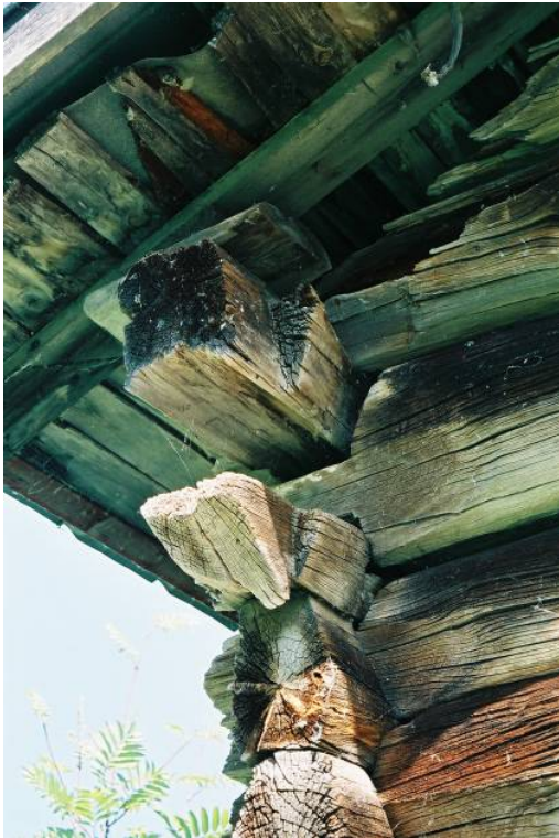
Bild 31. Detalj av væggbandets och underliggande stocks knutskallar. Jlm 06m56/29
