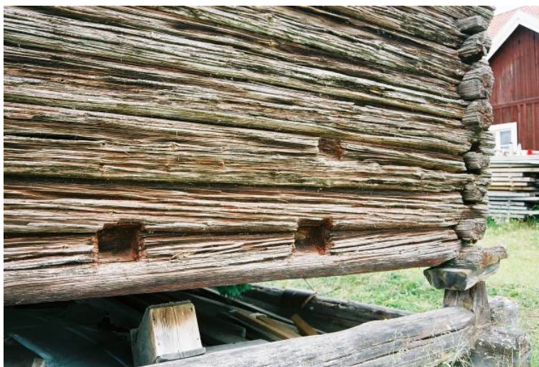
Bild 14. Urtag i B-vägg, möjligen efter åsar i en intilliggande byggnad. Jlm 06m54/34
