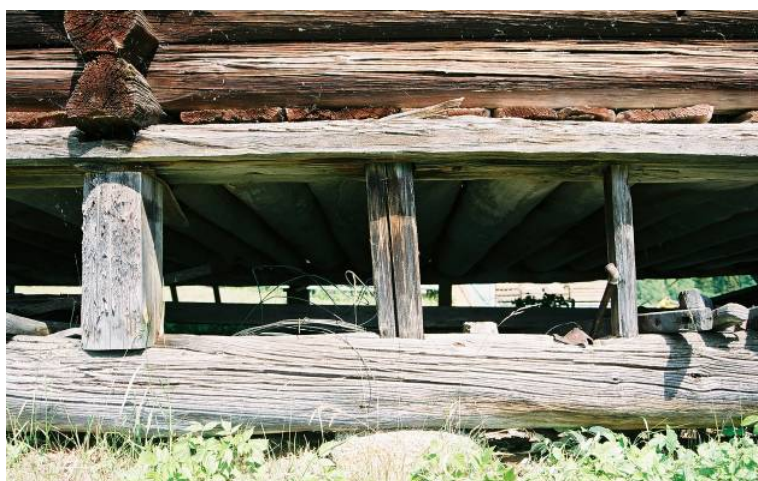
Bild 5. Mitt på C-väggen finns tre stolpar, varav den mittersta är äldst. Jlm 06m54/3
