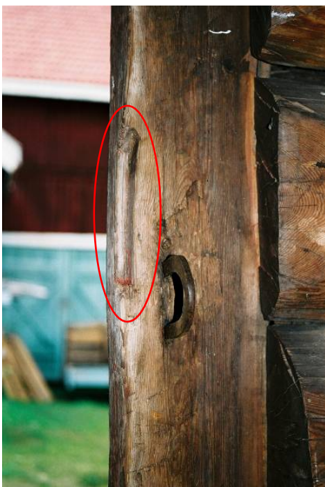
Bild 23, övre bilden: Låsbrickan på dörren till den högra boden. Notera den utstickande vertikala metalldelen. Jlm 06m54/20
