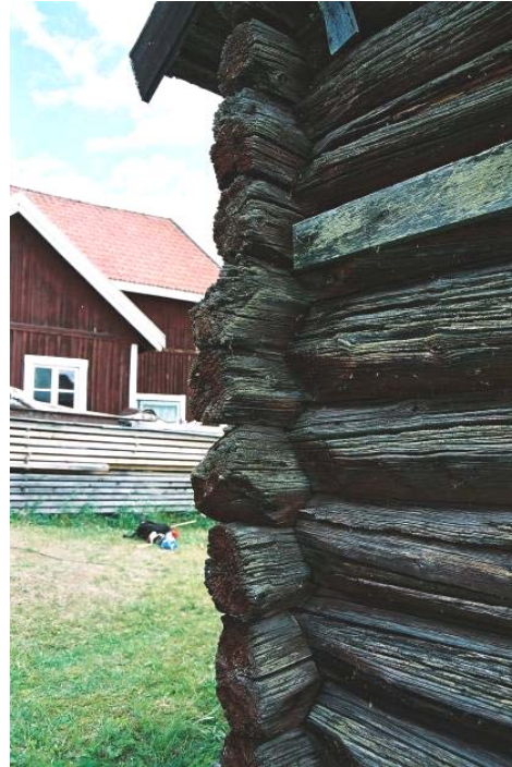
Bild 20. Knutskallarna i AD-knut är ojämnt avhuggna och obearbetade. Jlm 06m56/10
