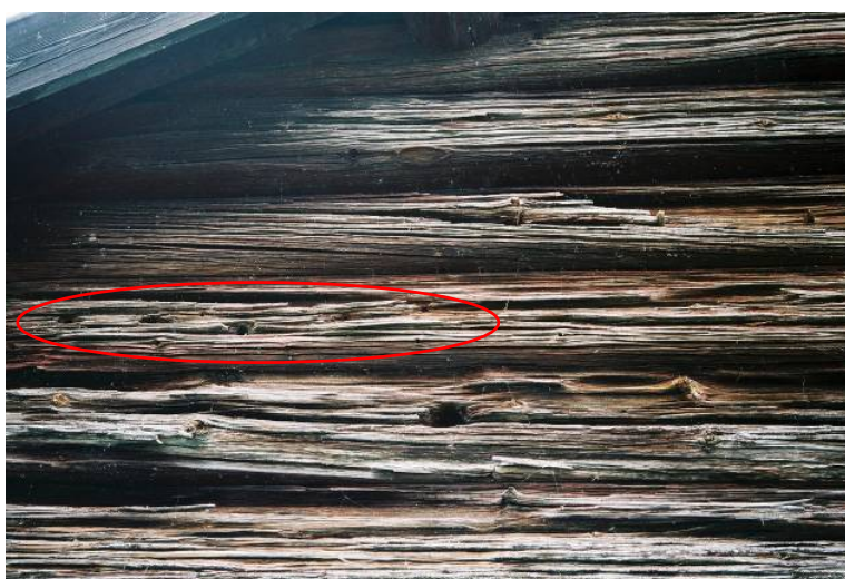
Bild 15. Lägg märke till de borrarade hålen som tyder på att väggen varit brädslagen. Jlm 06m54/33
