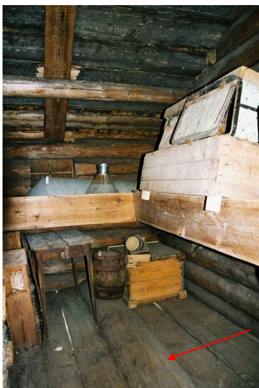
Bild 28. Interiör från den högra boden. Observera halvklovan på golvet som täcker springan för kilningen. Jlm 06m56/17
